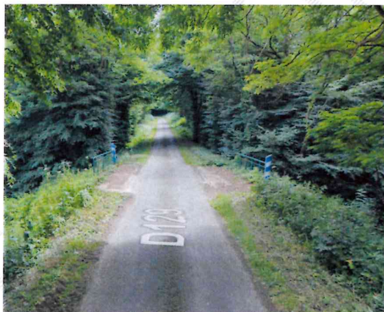
Pont traversée du Loir
